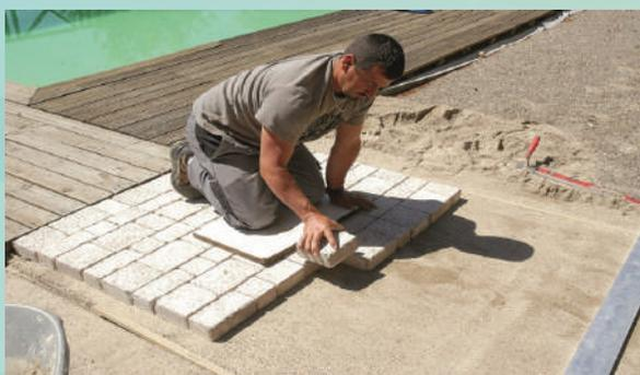
Ajustez la position des pavés à l'aide d'un maillet en caoutchouc.
